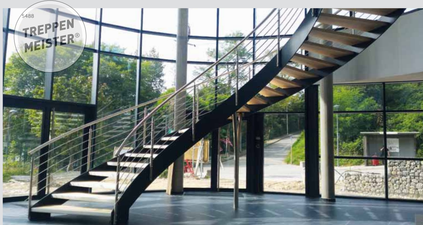
Magistral, cet escalier monumental réalisé dans un espace public donne le ton, il se joue de l'espace pour le magnifier. Une réalisation exceptionnelle d'alliance entre le métal et le bois.
